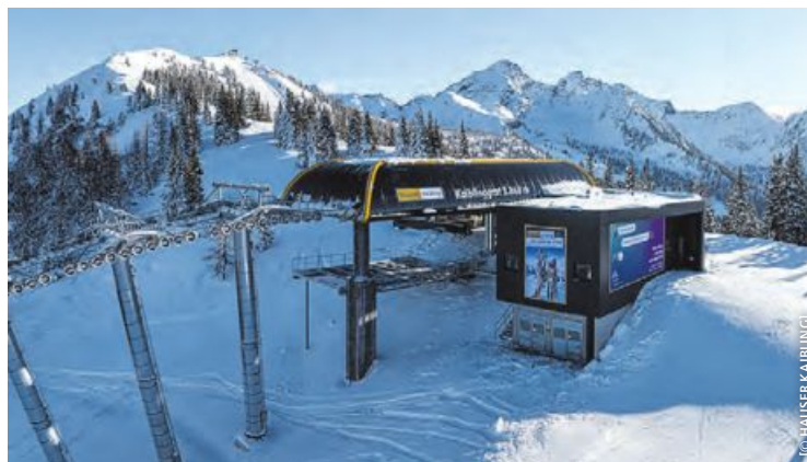
Mit einer Förderleistung von beeindruckenden 3600 Personen pro Stunde ist Kaiblinggrat 8er-Sesselbahn die stärkste Sesselbahn der Steiermark.
