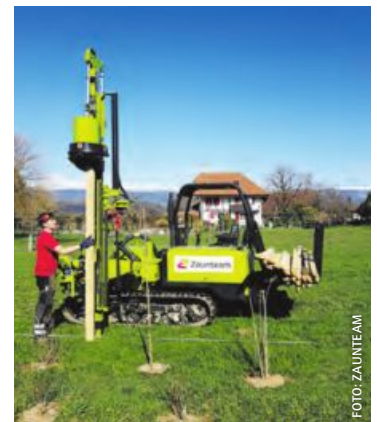
Der Spezialist Zaunteam sorgt für eine fachgerechte Montage.
