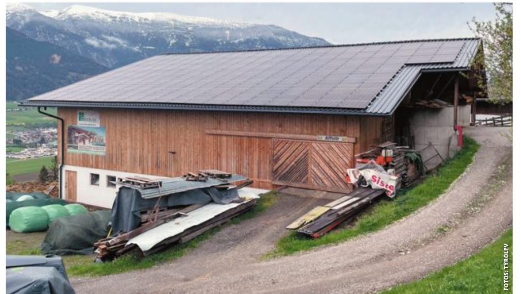
Der Schafflerhof am Arzberg in Schwaz ist durch seine Photovoltaik- und Stromspeicheranlage bereits energieautark. Aktuell werden Projekte zur Energieautonomie in der Landwirtschaft gefördert.
