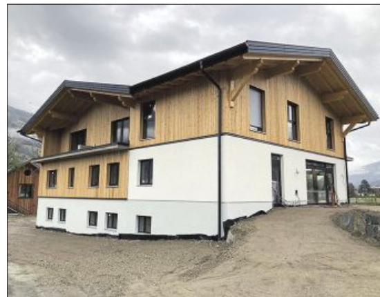
Holzbau in Vollendung: Gewerbezeile mit drei Apartments im Dachgeschoß.
