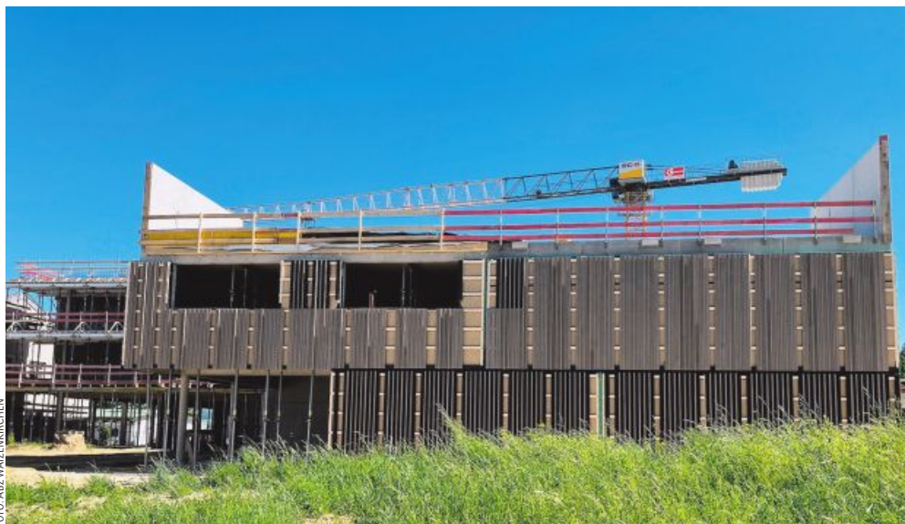
Ein modernes Gebäude nimmt Formen an: das neue Agrarbildungszentrum Waizenkirchen
