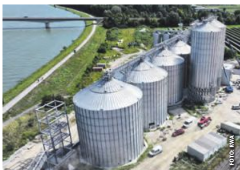
22.000 Tonnen Lagervolumen wurden errichtet.
