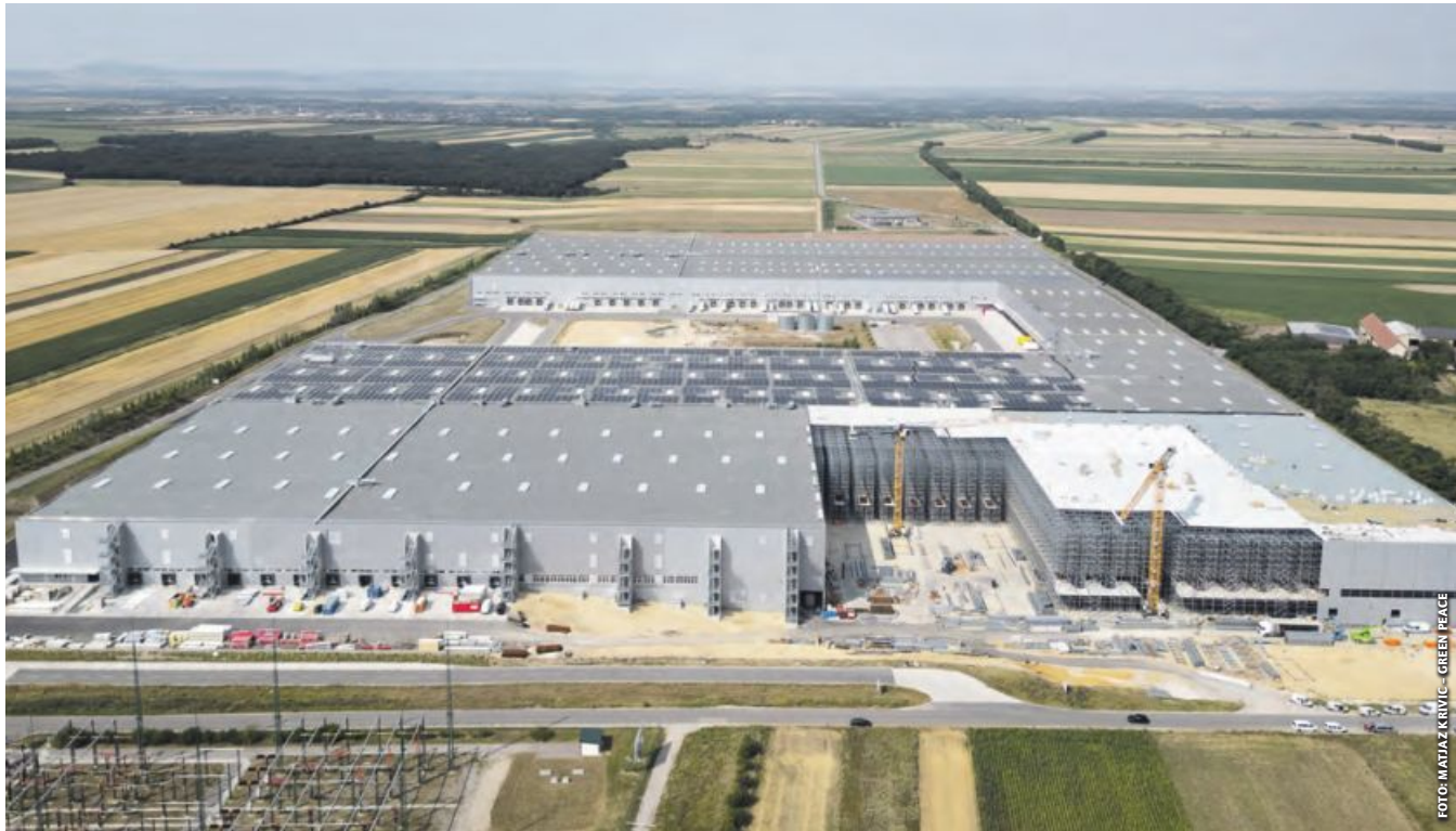
Nahe an der Autobahn A4 und mitten in den Äckern beansprucht das XXXLutz-Zentrallager in Zurndorf eine Grundfläche von 40 Hektar. In der Greenpeace-Kampagne „Betonerschätze“ landete das Bauwerk als Spitzenreiter im Burgenland unter den neun Finalisten.
