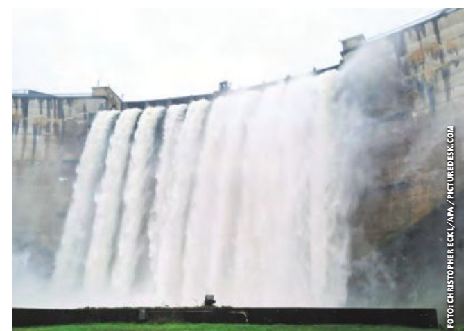
Der Stausee Ottenstein musste kontrolliert abgelassen werden.
