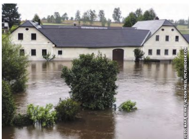
So mancher Bauernhof samt Keller und Stall wurde geflutet.
