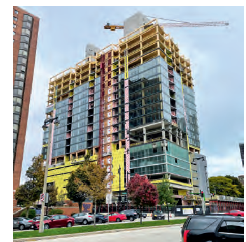
In der Bauphase gut sichtbar die Verwendung der Holzbalken .
