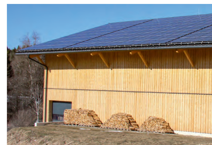
Installation von PV-Anlagen auf den Hofdächern begann 2020 mit der Errichtung der neuen Heuhalle. In Summe sind es vier.
