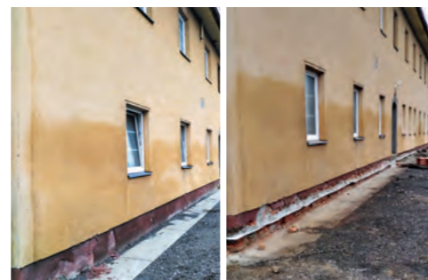
Hof-Sanierung durch Hydro-Isolation mit patentierter HIO-Technologie.
