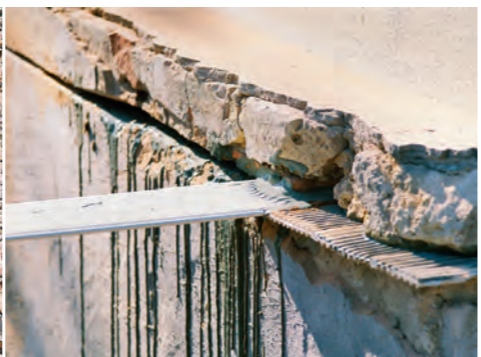
HIO-Verfahren: Feuchte Mauern werden horizontal geschnitten und mit einer speziellen Masse eine Masterschiene fixiert.
