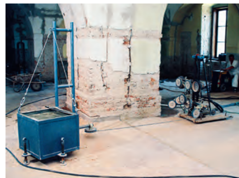
HIO-Verfahren: Feuchte Mauern werden horizontal geschnitten und mit einer speziellen Masse eine Masterschiene fixiert.
